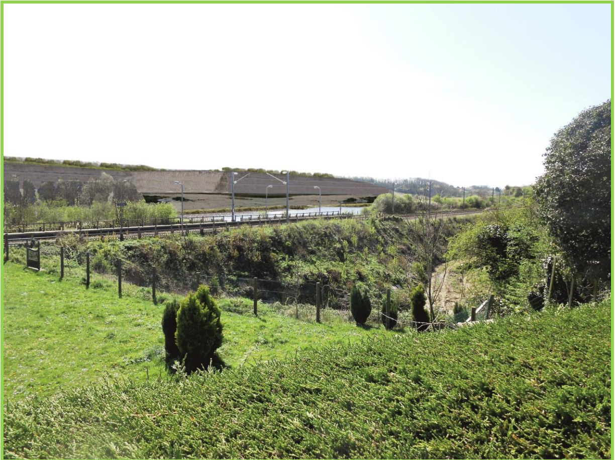
Vue des fronts de taille partiellement végétalisés depuis les habitations au Nord de la carrière
